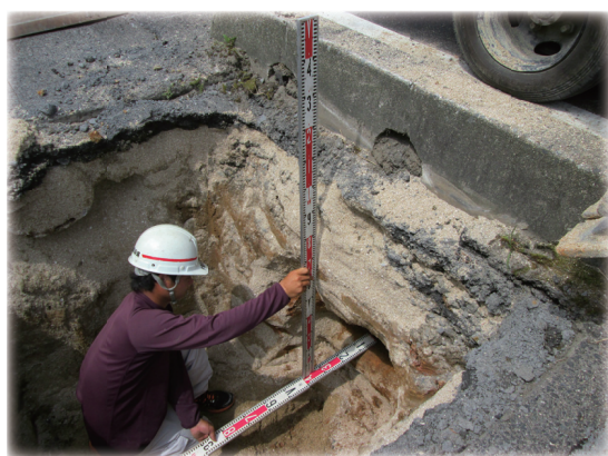
既設管埋設位置確認の様子
