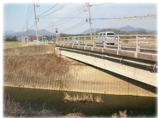
市内橋梁添架管
