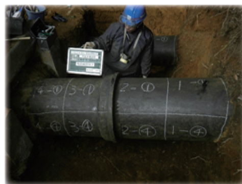
配水本管の管体土壌調査の様子
