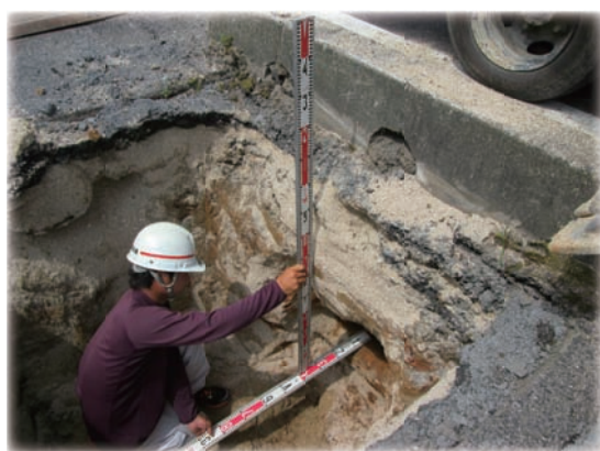
既設管埋設位置確認の様子
