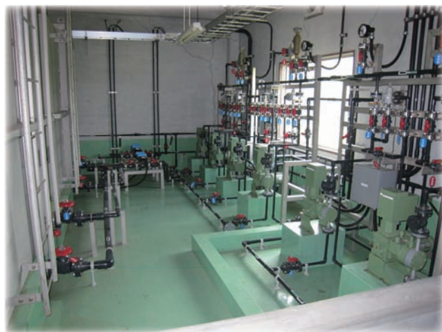
薬液注入施設
