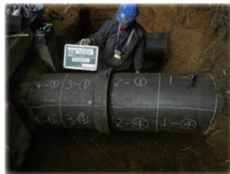
配水本管の管体土壌調査の様子
