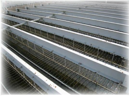
▲傾斜板沈殿池
