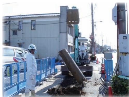
▲配水管布設替工事における経年管（石綿管）撤去の様子
