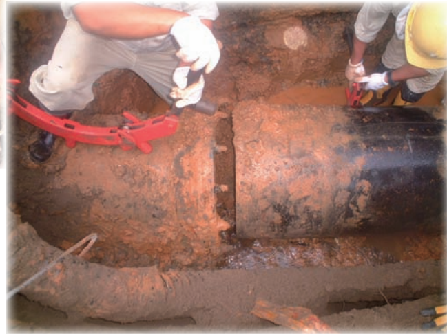
▲新潟県中越地震により破損した水道管復旧の様子（写真提供：新潟市水道局）
