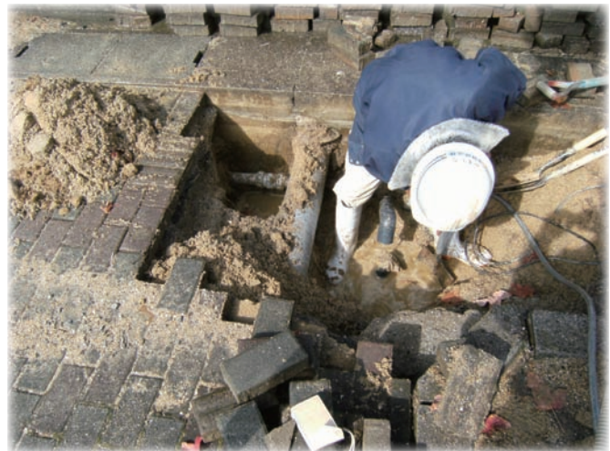
▲配水管破損による修理の様子
