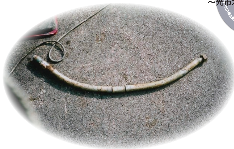
▲漏水修理において撤去された鉛製給水管
