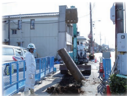
▲配水管布設替工事における経年管（石綿管）撤去の様子
