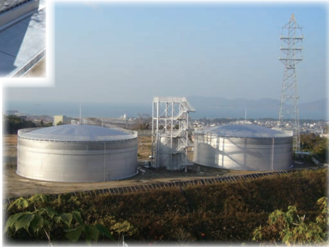
▲平成 19 年度に完成した上ヶ原配水タンク(左上)、清山配水タンク(右下)
