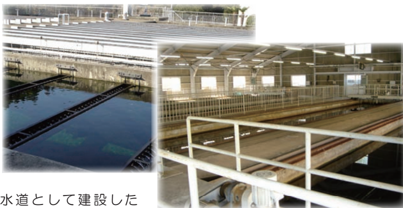
▲更新が必要な沈殿池(左)、ろ過池(右)
