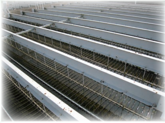
▲傾斜板沈殿池
