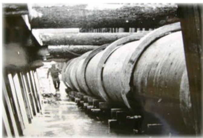
▲昭和40年代に行った集水管埋設の様子(第3号集水管)
