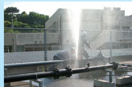
平成24年 第18回内部研修 配水管破損修理
