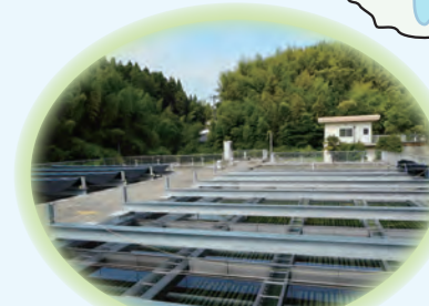
平成28年度に更新した沈殿池傾斜管 (林浄水場内)
