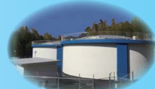
樋口配水池(周南市)
