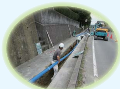
▲ 耐震管への布設替の様子
