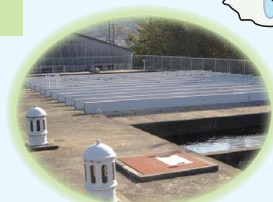
平成28年度に更新工事予定の沈殿池傾斜管 (林浄水場内)
