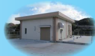
熊毛地区送水ポンプ所(林浄水場内)
