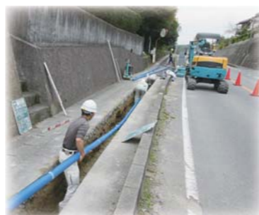
▲老朽水道管布設替工事
